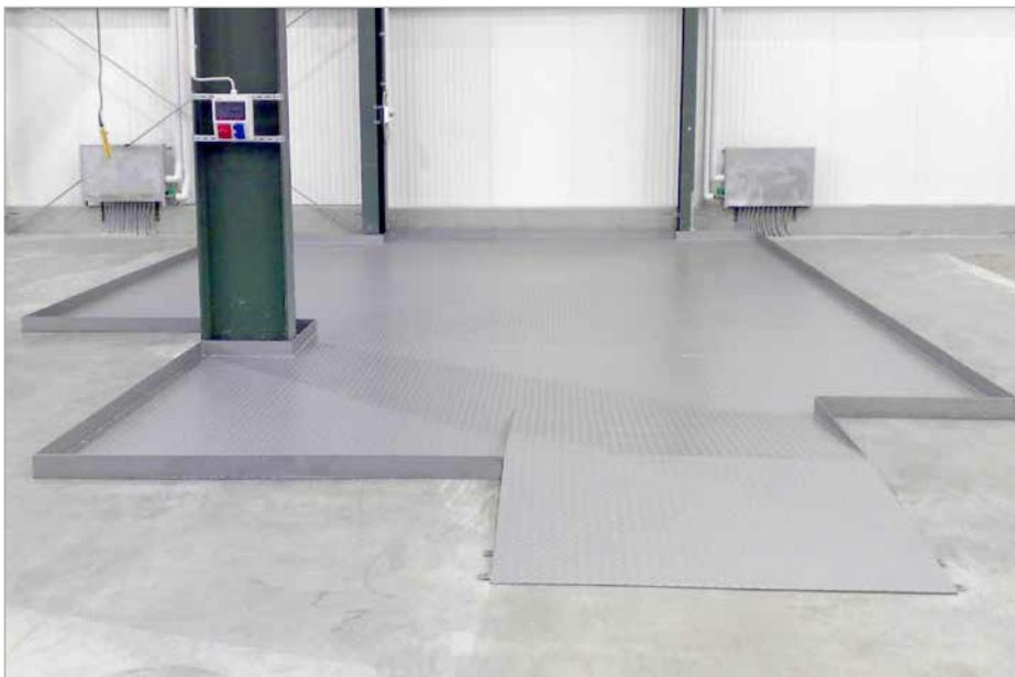
Bodenschutz-Auskleidung mit Aussparung für Pfeiler und Überfahrrampe
